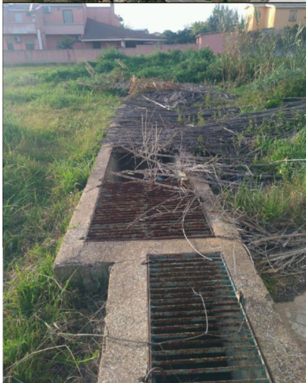
Foto 7 - cisterna interrata nell'area 11. Una parte delle grate di protezione è stata rimossa/è precipitata ed il buco è stato coperto con delle canne
