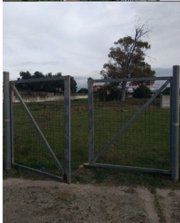
Foto 6 - cancello d'accesso all'area 11, sprovvisto di serratura o lucchetto.
